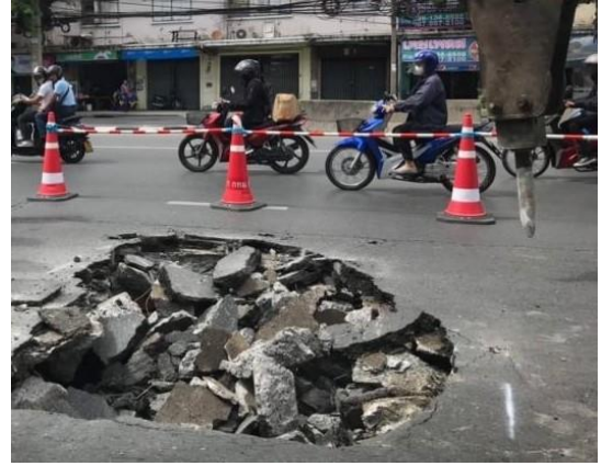
ภาพที่ ๒ สภาพถนนทรุด ในพื้นที่กรุงเทพมหานคร
