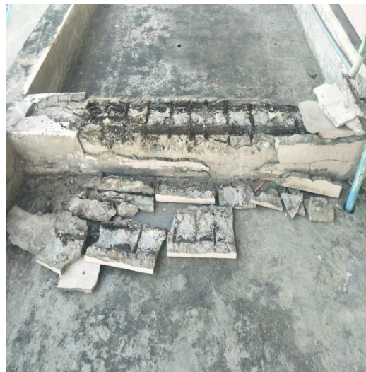
ภาพที่ ๑ สภาพโครงสร้างคานคอนกรีตเสริมเหล็ก ผุ กร่อน ในพื้นที่กรุงเทพมหานคร
