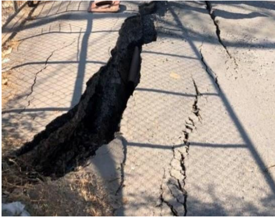
ภาพที่ ๒ สภาพถนนทรุด ในพื้นที่กรุงเทพมหานคร
