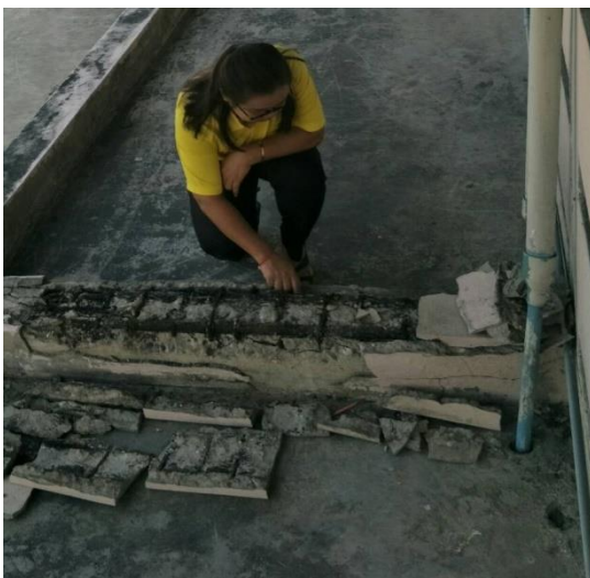
ภาพที่ ๑ สภาพโครงสร้างคานคอนกรีตเสริมเหล็ก ผุ กร่อน ในพื้นที่กรุงเทพมหานคร
