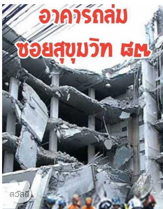
ภาพที่ ๒ อาคารถล่ม ซอยสุขุมวิท ๘๗
