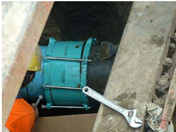
รูปที่๑๓ การขันสลักเกลียว และน็อต
