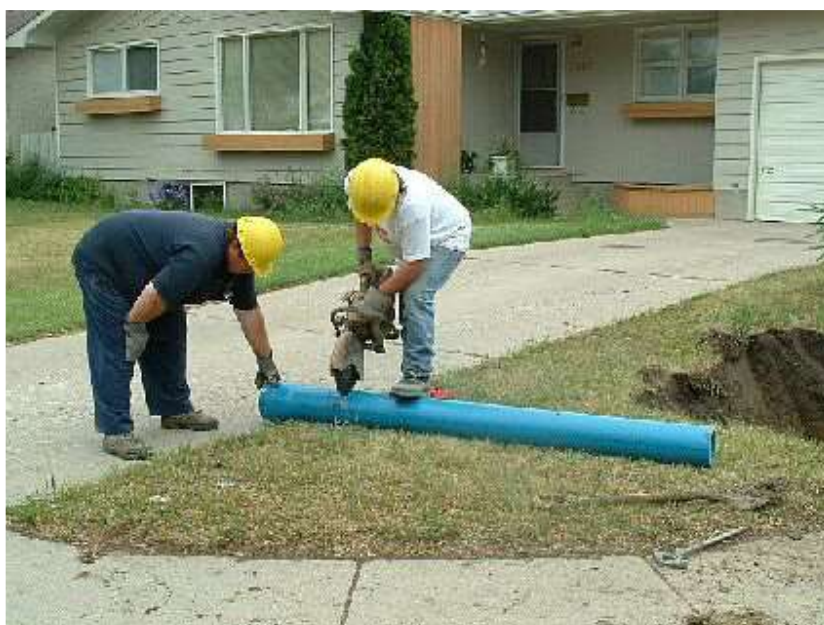
รูปที่ ๗ การตัดท่อใหม่ที่จะใช้เปลี่ยน
