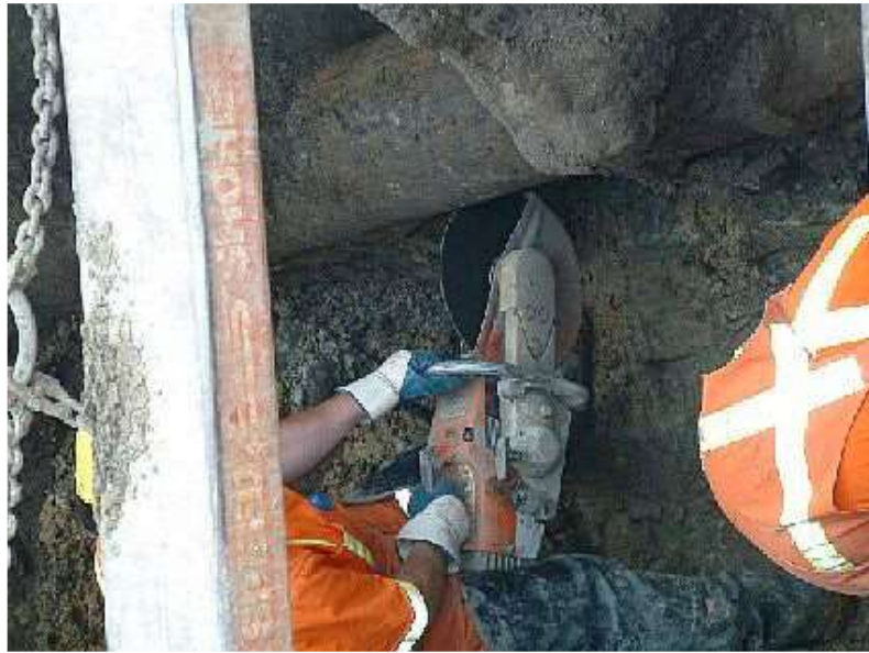
รูปที่ ๒ การตัดท่อจากกลางขึ้นบน
