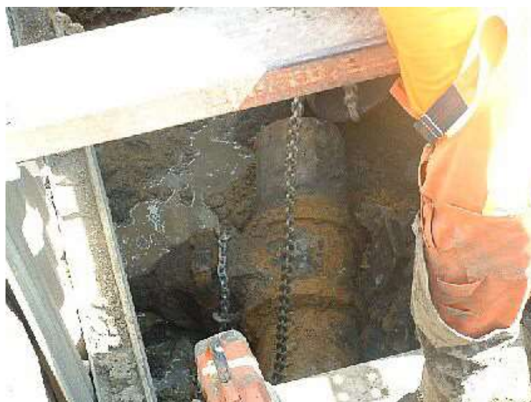
รูปที่ ๕ ย้ายท่อที่แตกออกโดยใช้รถขุดช่วยยก
