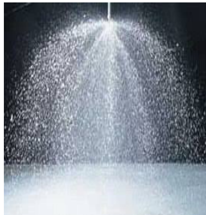
สปริงเกอร์ฉีดน้ำ
