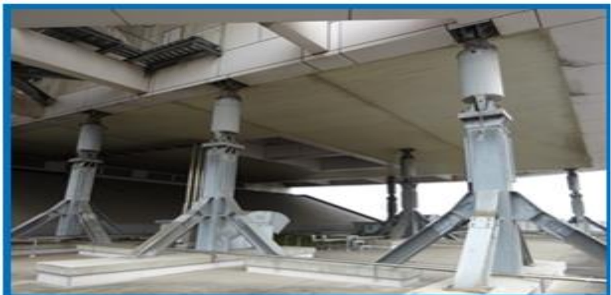
ภาพที่ ๑ - ๑๑ : โรงพยาบาลควาซากิทำจากโครงสร้างที่ทนต่อแผ่นดินไหว
