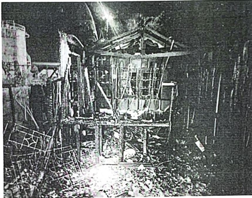
ภาพบ้านนักเรียนที่ประสบอัคคีภัย วันเสาร์ที่ ๓๐ ธันวาคม ๒๕๖๖
