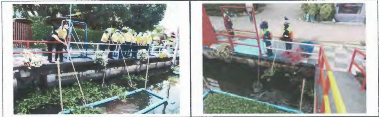
ภาพก่อนดำเนินงาน
