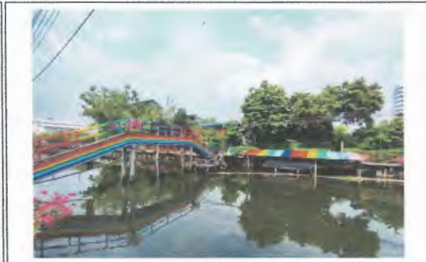
ภาพหลังดำเนินงาน
