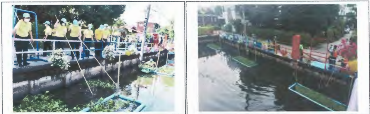
ภาพหลังดำเนินงาน
