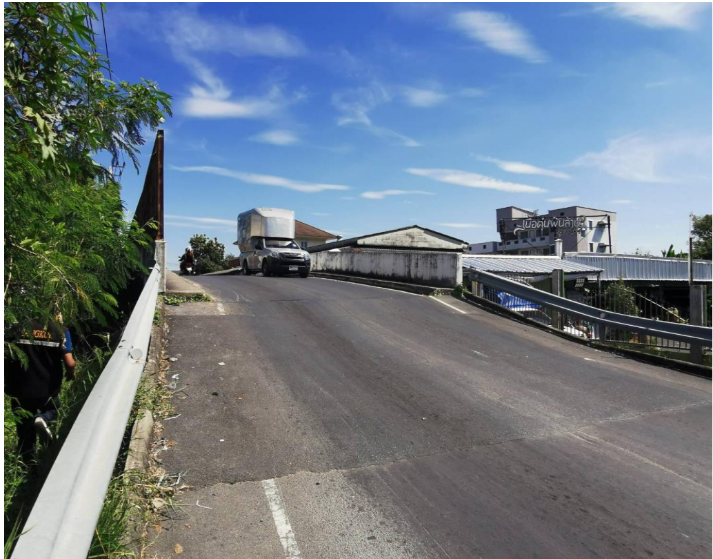
รายการที่ 4 ปรับปรุงเชิงลาดสะพานข้ามคลองจวนซอยอ่อนนุช 39 งบประมาณ 7,882,000 บาท
